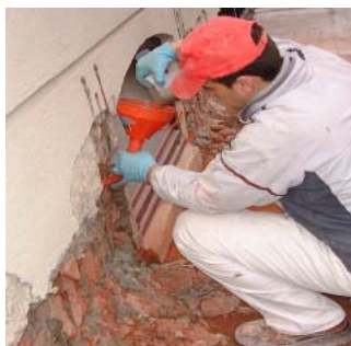
Introduzione per caduta di impregnante Mursan® Olosil
