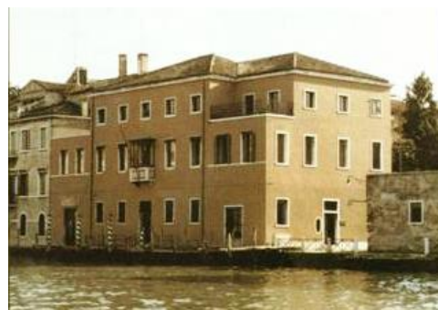
Palazzo veneziano dopo l'intervento di risanamento mediante applicazione di intonaco macroporoso a base di calce idraulica realizzato con additivi MURSAN® M1 e M2
