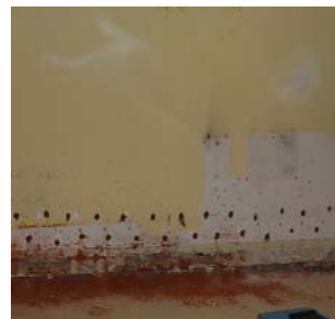
Particolare di muratura ove si evidenzia la disposizione "a greca" dei fori
