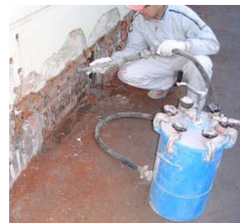
Iniezione a bassa pressione di speciale betoncino osmotico Mursan® M7/A o Mursan® M7/B
