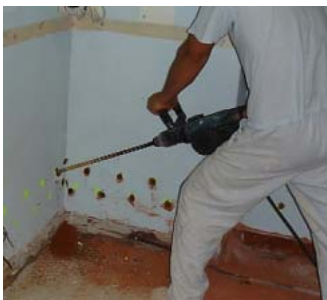
Esecuzione dei fori alla base della muratura
