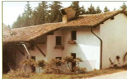
Fabbricato rurale dopo il risanamento effettuato con intonaci macroporosi realizzati con additivi MURSAN® M1 e M2
