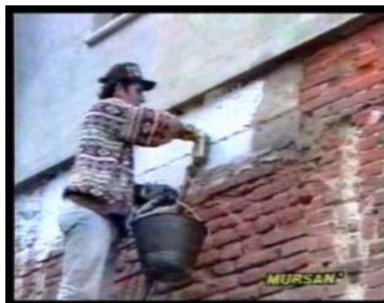
Applicazione della miscela su supporto liscio prima dell'esecuzione di un intonaco macroporoso Mursan®
